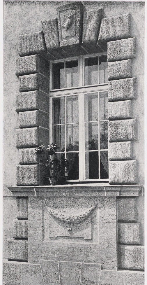
Abb. 80. Direktorhaus. Fenster des Erdgeschosses.
